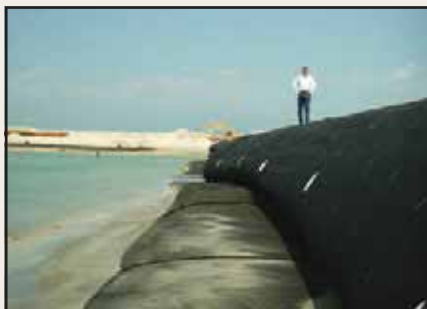
As unidades Geotube® podem ser empilhadas.
