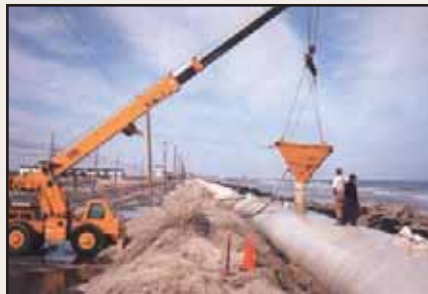
Unidade Geotube® sendo preenchida com areia utilizando um funil.
