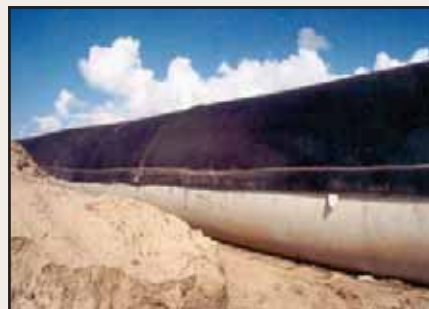
Proteção das unidades Geotube® contra os danos causados pelos raios UV.
