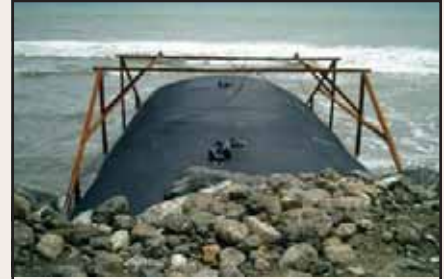
Unidade Geotube® sendo sustentada pelo gabarito metálico enquanto é preenchida.
