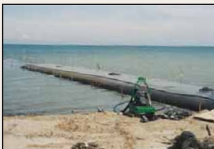
Unidades Geotube® sendo posicionadas.
