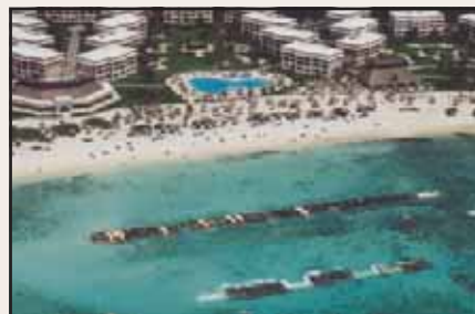
Unidade Geotube® instalada em mar aberto como estrutura de quebra-mar.
