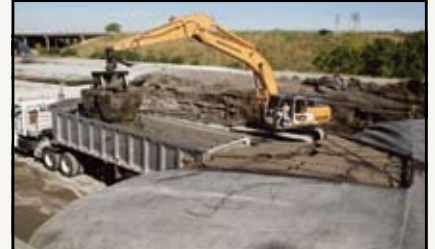
Il materiale disidratato viene rimosso dai Geotube® al termine della fase di consolidamento.
