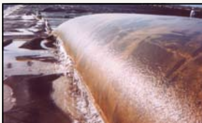
L'acqua che fuoriesce da TenCate Geotube® durante la fase di riempimento
