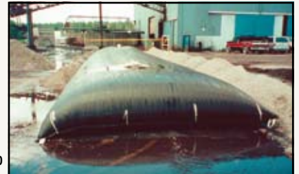
Dewatering fanghi derivanti dalla lavorazione del carbone mediante l'impiego dei TenCate Geotube®
